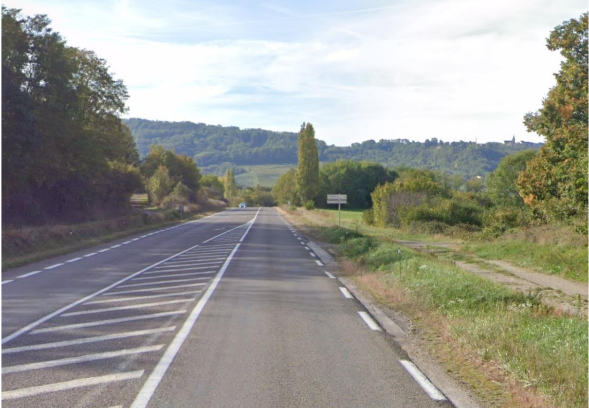
Accès futur par la RD 471. Google Earth
