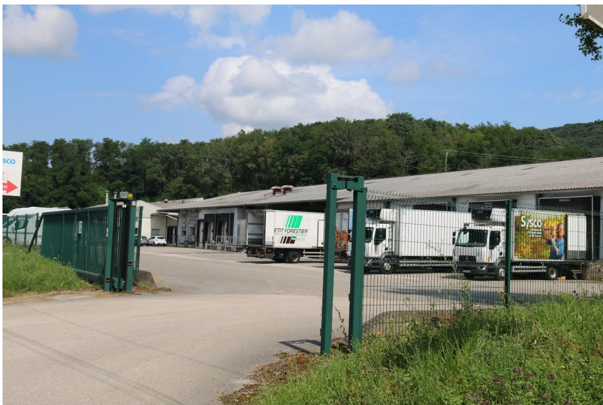
L'abattoir existant. Photographies prises le 7 août 2024
