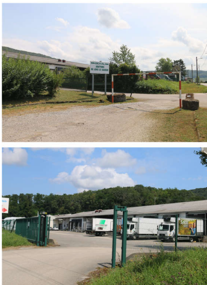
FIGURE 5 – L'ABATTOIR EXISTANT (SOURCE : IAD PHOTOGRAPHIES DU 7 AOUT 2024)
