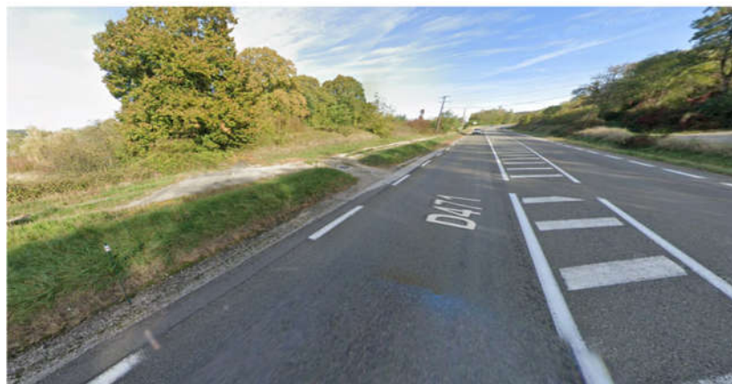
FIGURE 14 - VOIE D'ACCES ROUTE DEPARTEMENTALE RD471
