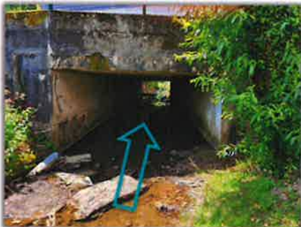
Tronçon couvert amont
