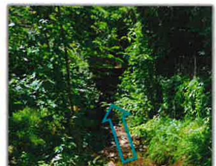
Tronçon couvert aval
