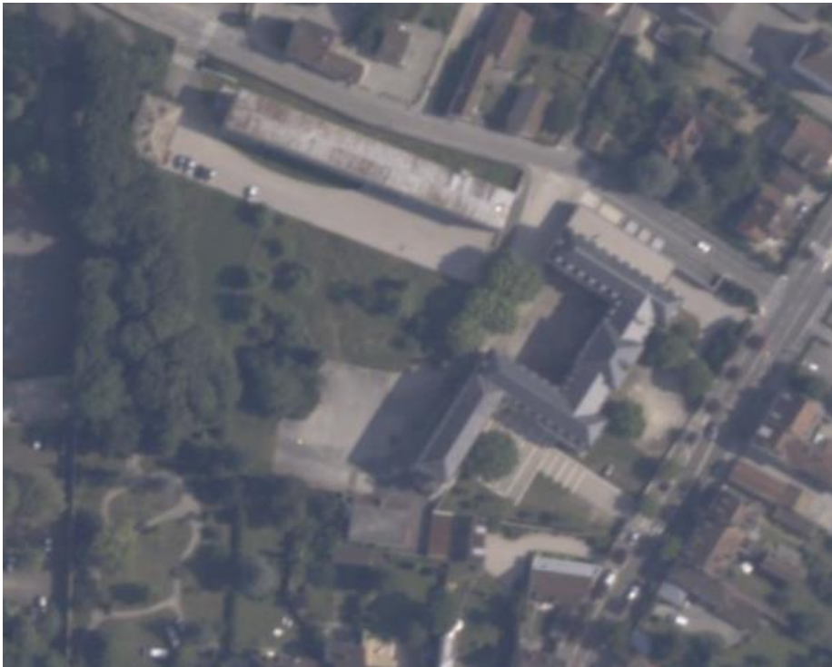
Vue du site en 2010 – Source – IGN remonter dans le temps
