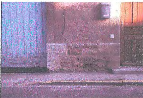
Soubassement saillant en pierre de taille : fonction esthétique, mais aussi protection de l'enduit en partie basse
