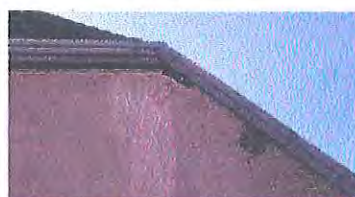
bande de rive au ras du pignon
