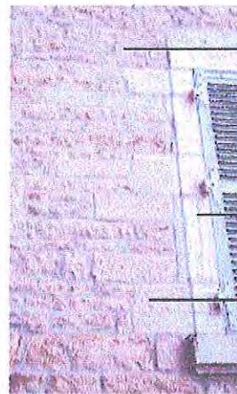
encadrement de fenêtre en pierres dures destinées à supporter les efforts
